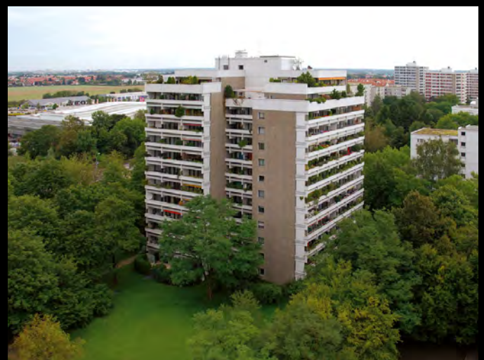
Wohngebäudekomplex im Ahornring in Taufkirchen mit BIOCAT WS-Großgerät
