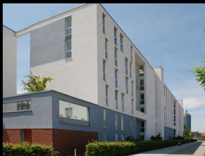
Wohngebäudekomplex im Max-Friedländer-Bogen in München mit BIOCAT KS 14000, ausgelegt für 110 Wohneinheiten
