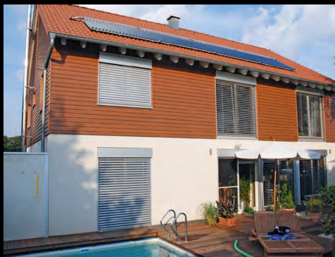
Einfamilienhaus mit BIOCAT KS 3000 Kalkschutzgerät
